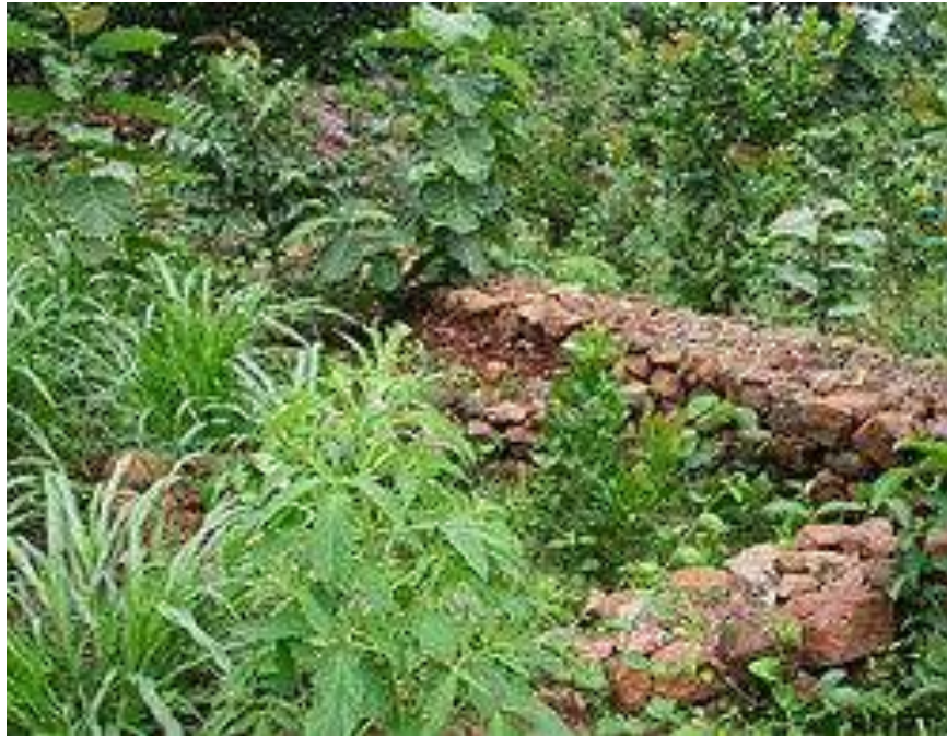
حوائط مبنية لتجنب انسياب المياه
